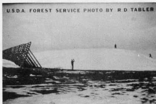
図1 アメリカのワイオミング川では風が強くて雪が飛んでゆく。そのような平原に柵をつくり、吹き溜りを作って、雪を貯め、その融け水を池にため家畜の飲料水にしている。
