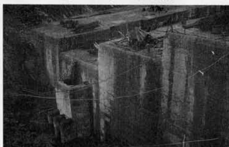
当時の有峰ダム工事現場
