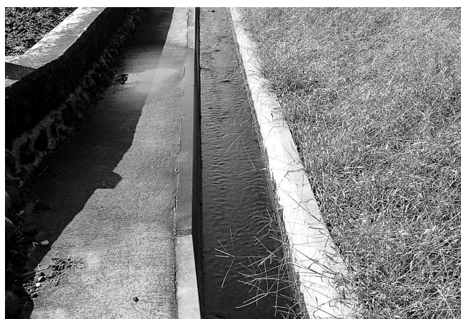
図4 黒部市田家新(2016年11月4日撮影)。 図3と同所。三面張りコンクリートに改修された。
