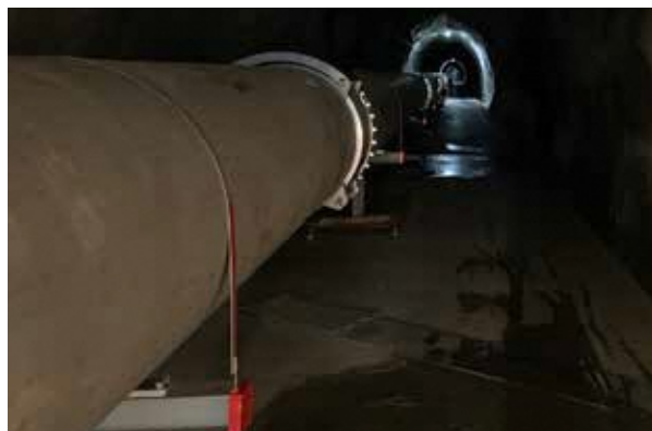
図7. 現在の3キロメートルのトンネルの様子。直径80センチメートルの真空パイプがほぼ完全に一直線に設置され、その中をレーザー光が行き来します。
