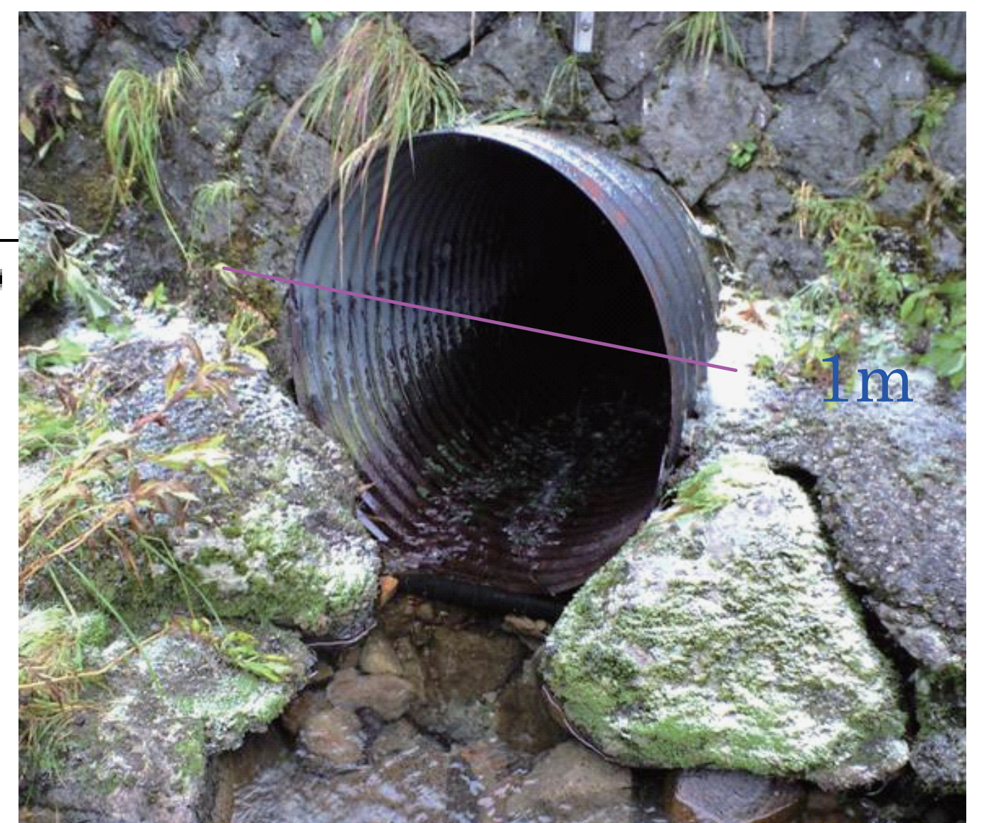
図6-10 碁石谷の水位計設置場所
