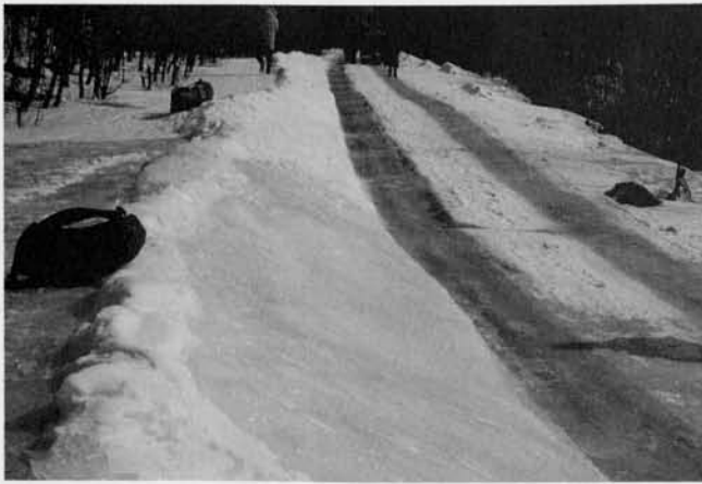
図5 斜面からの地下水が凍る延流水
