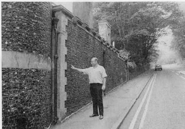
図9：ドーバー海峡付近の建物の壁。フリントを積み上げて造られている。
