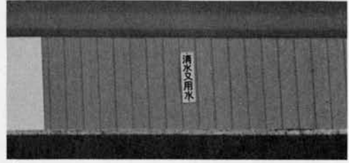
常西合口用水からの取水口の機械室壁面にある、清水又用水の表示
