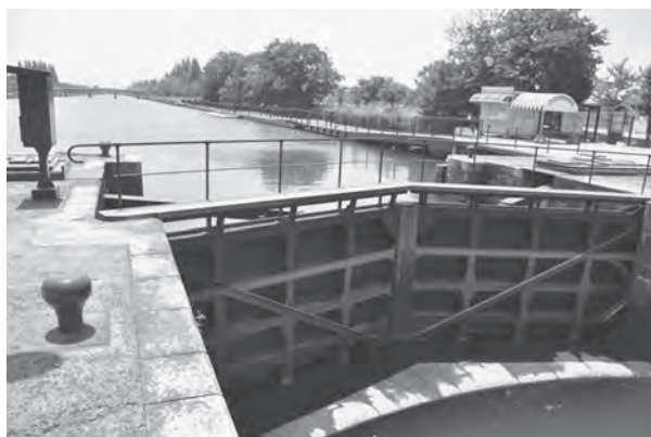
図6 中島閘門の上流側扉体（上が上流側）
